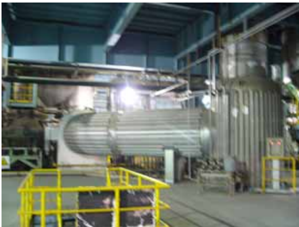
Главный затвор парэжекторного насоса
